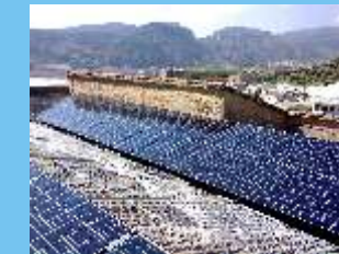
Fotovoltaico, 49kw - Alicante ES
